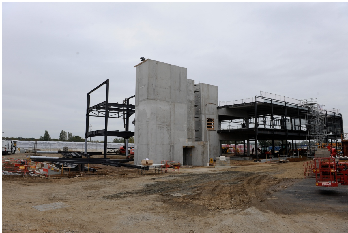
Avancement des travaux au 23 octobre 2014
